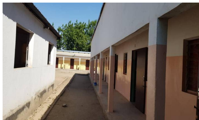
Un des bâtiments vétuste de l'hôpital
